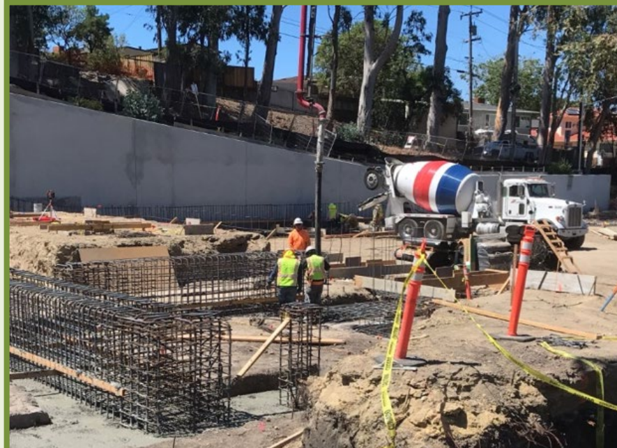
CONCRETE FOUNDATION POUR
